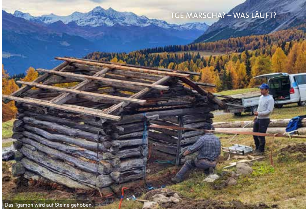
Das Tgamon wird auf Steine gehoben.
