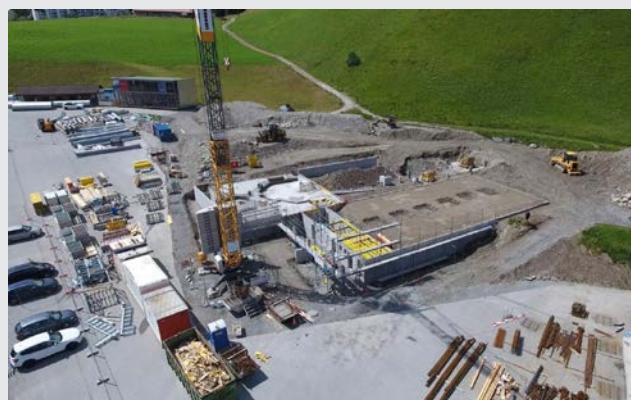
Bau der Talstation
